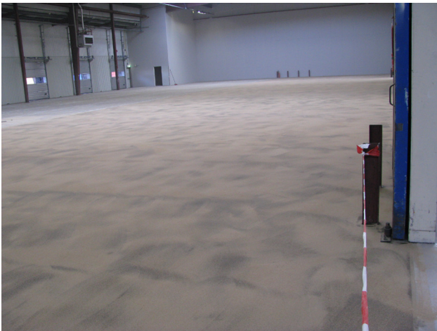
Figuur 5.4: Onregelmatige dekking met als resultaat vlekkerig beeld
