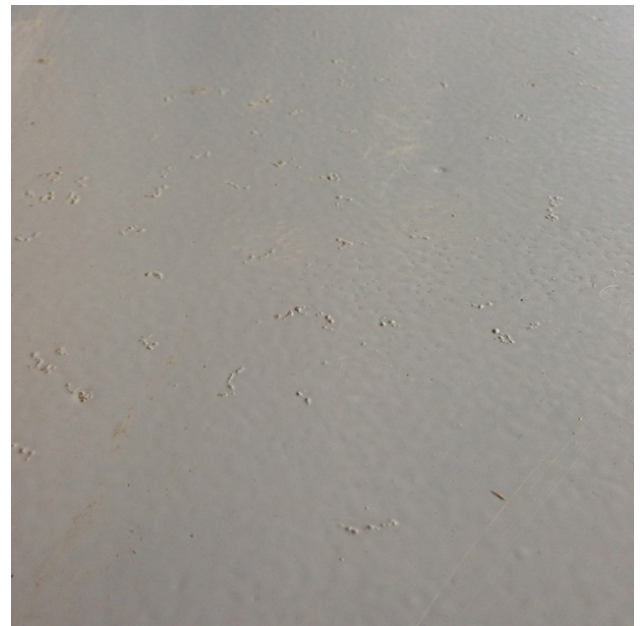
Figuur 5.2: Uitstekende delen in de coatinglaag
